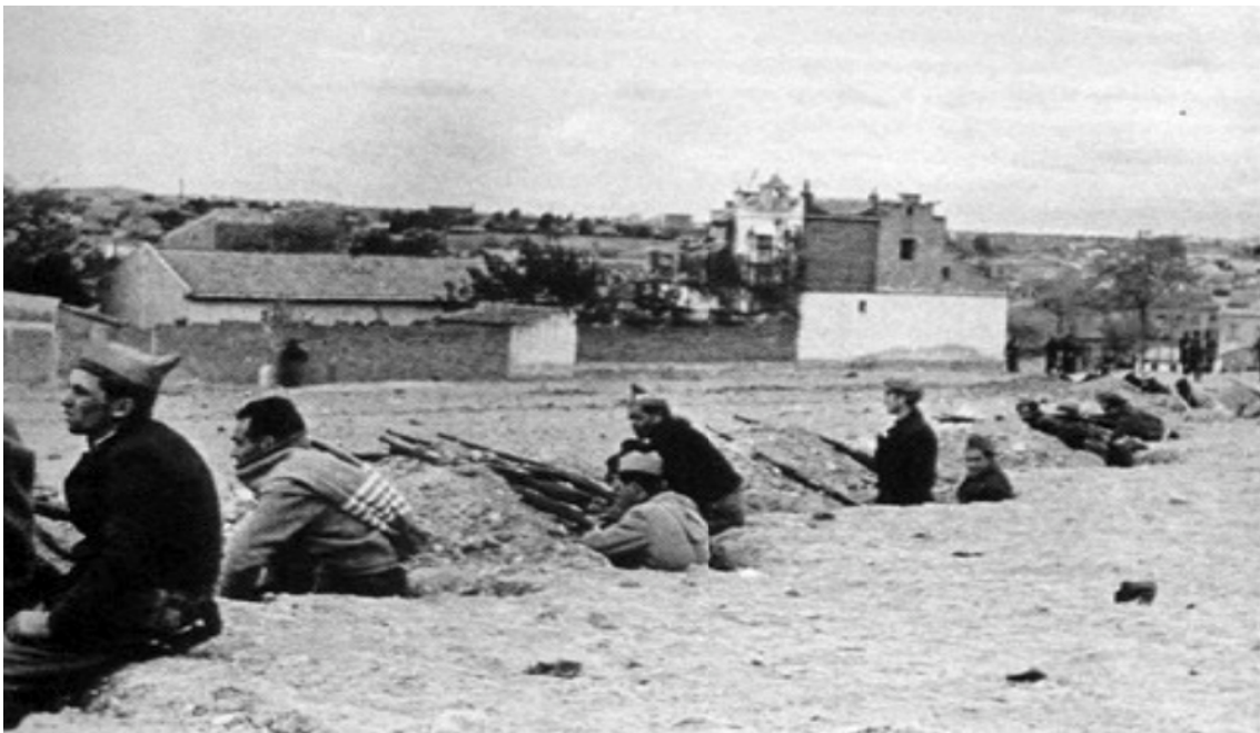
Trinchera en los alrededores de Madrid en otoño de 1936. Fuente desconocida. Nótese el trazado rectilíneo con zigzags poco marcados, zanja poco profunda y parapeto somero.
