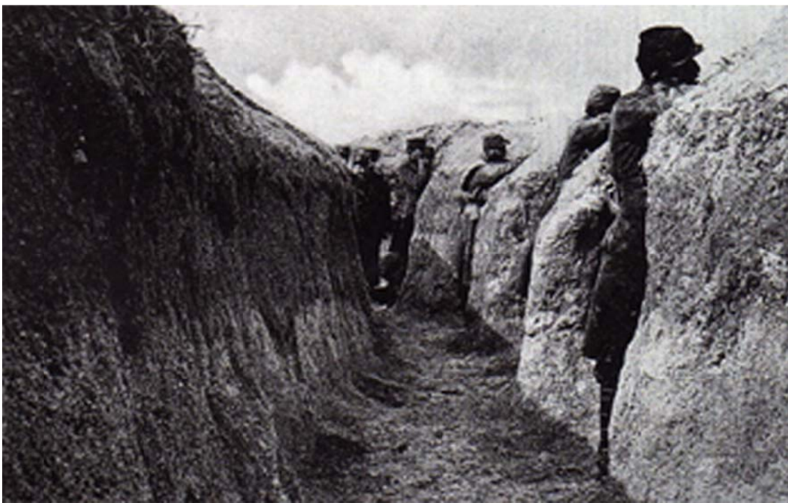
Trinchera francesa de comienzos de la guerra con trazado rectilíneo y numerosos puestos de tirador.
